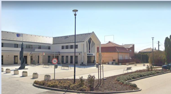
Rendelkezésre álló meglévő épület a városháza közelében, Hősök tere 1. (google map)
