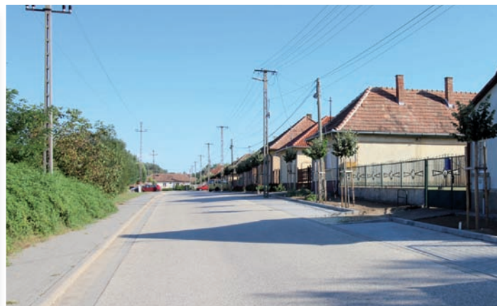
Homok utca korszerűsítése
